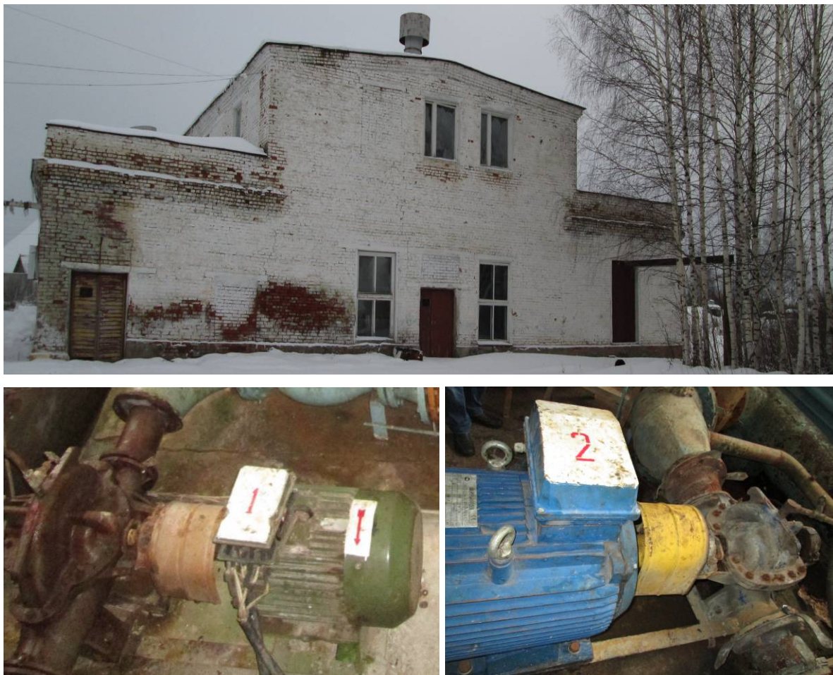
Рис. 1.8. Здание ВОС и основное насосное оборудование НСВП
