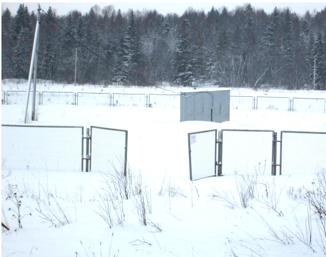
Рис. 1.10. Павильон артезианской скважины посёлка Балезино
