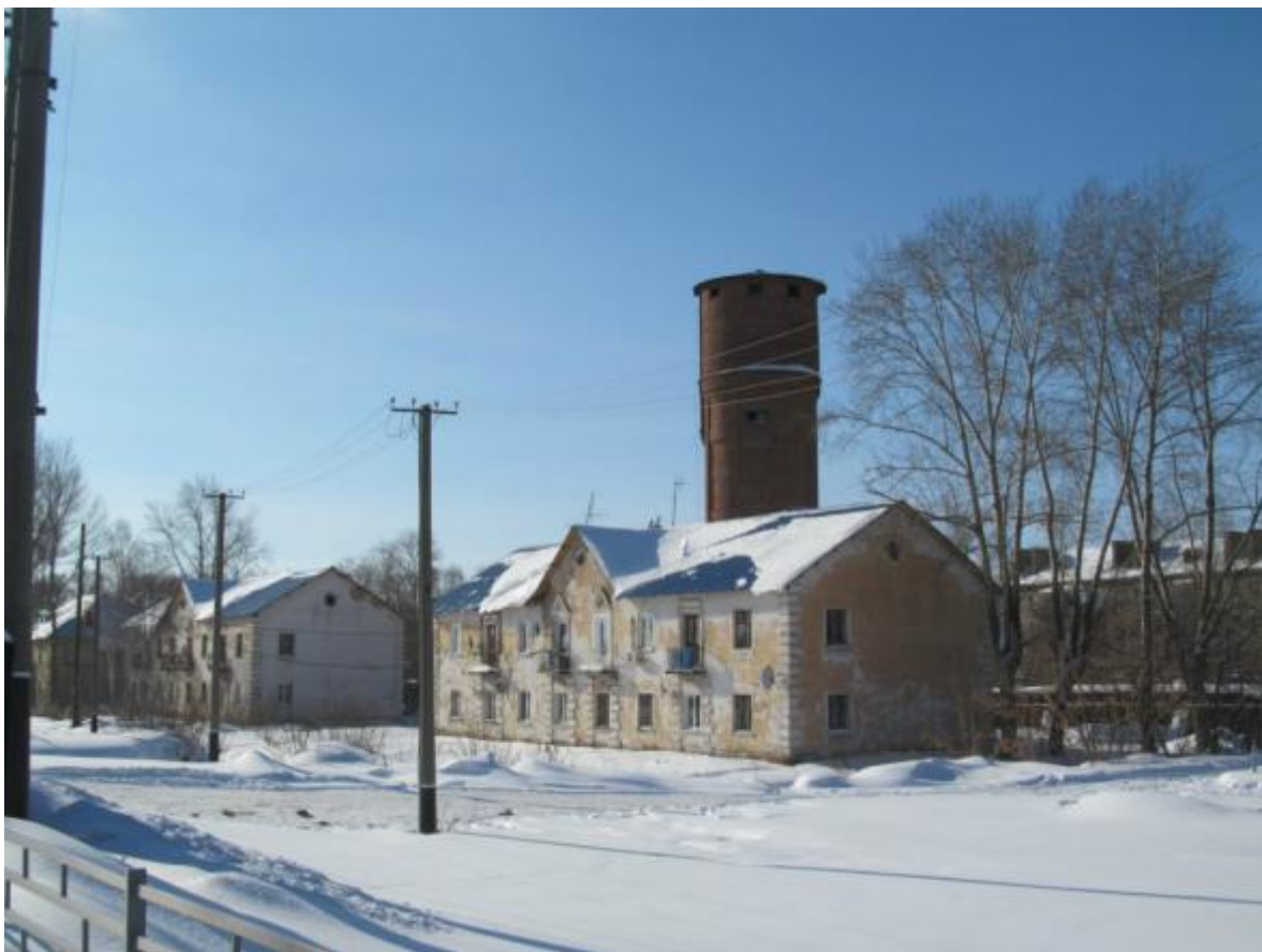
Рис. 1.9. Водонапорная башня посёлка Балезино
